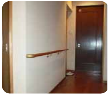
手すりの設置
