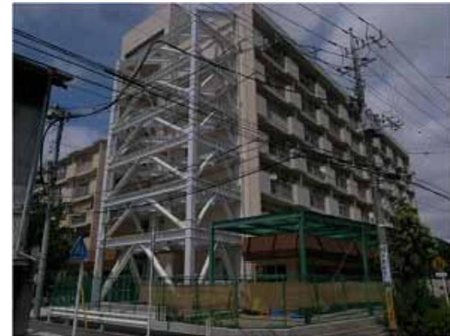
バットレス補強の事例
