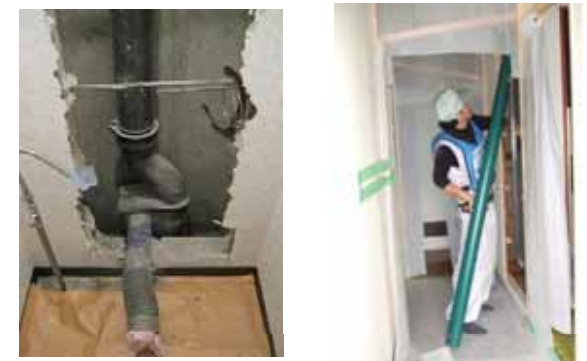
専用部内の排水立て管更新
