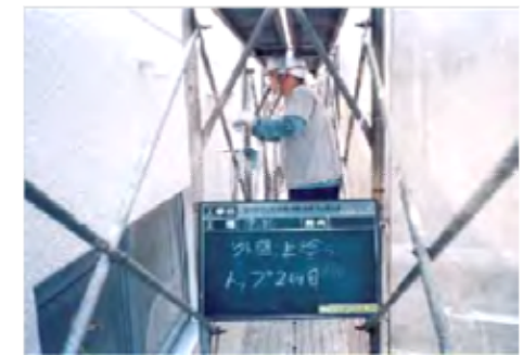
塗装・吹付け直しの例
