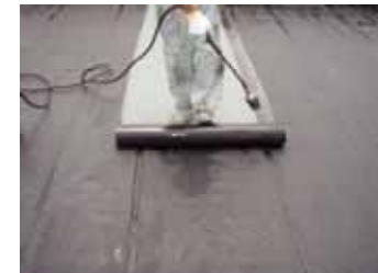
かぶせ工法による屋上防水改修
