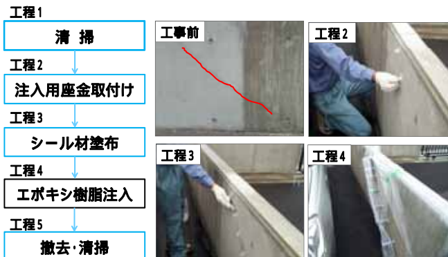
ひび割れの補修事例
