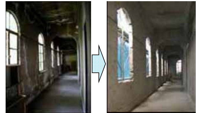
求道学舎(築後約80年)の躯体改修
