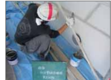
充てん工法によるひび割れ補修
