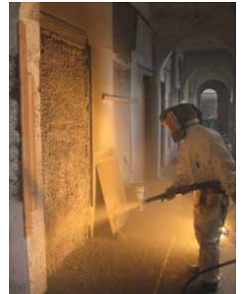
吹付けコンクリート施工
