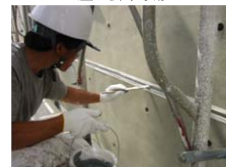
シーリング改修
