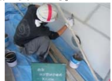
充てん工法によるひび割れ補修
