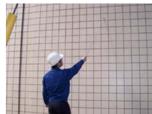
打診法による外壁タイルの浮きの検査(非破壊検査)
