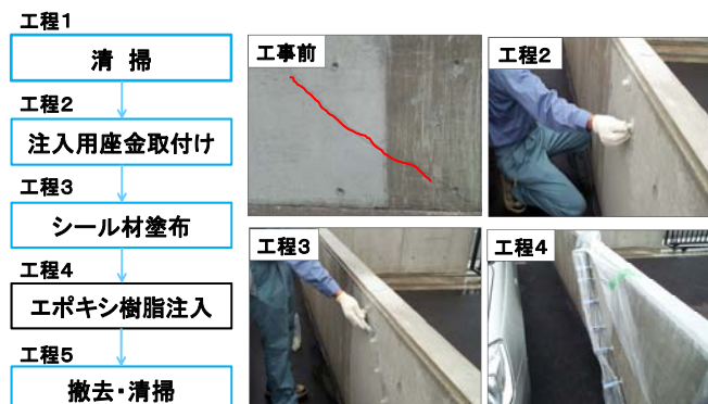
ひび割れの補修事例
