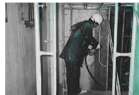
劣化部分の除去
