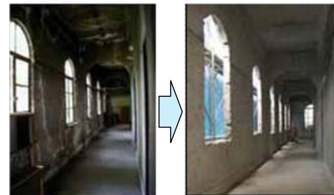
求道学舎（築後約80年）の躯体改修
