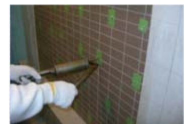
アンカーピンニング・注入併用工法によるタイルの浮きの補修
