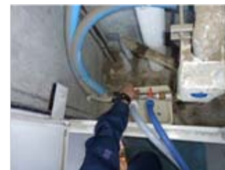
オゾン洗浄水方式による給水管洗浄
