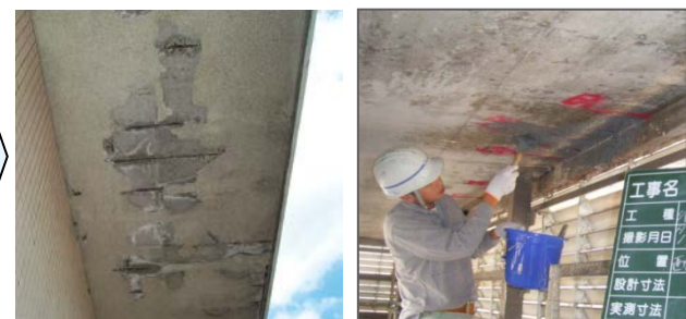
断面修復工法による補修
