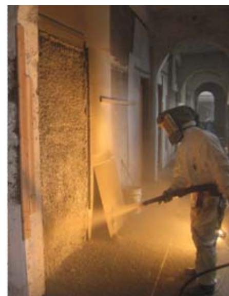
吹付けコンクリート施工
