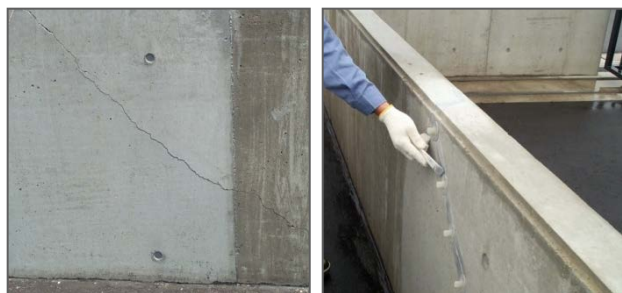
注入工法による補修
