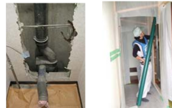
専用部内の排水立て管更新
