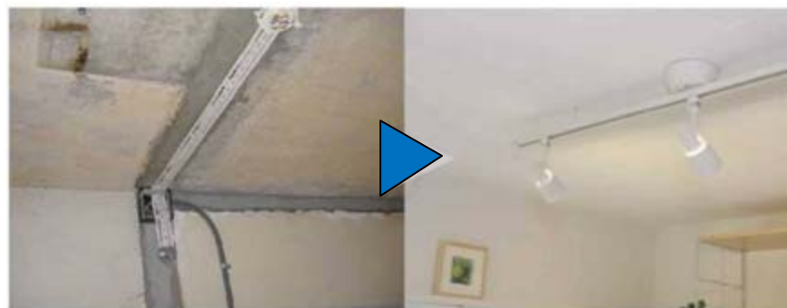
コンクリート直天井面における平形保護層工事
