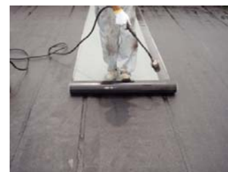
かぶせ工法による屋上防水改修
