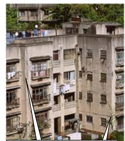
建物出隅部でのコンクリート剥落・鉄筋露出
