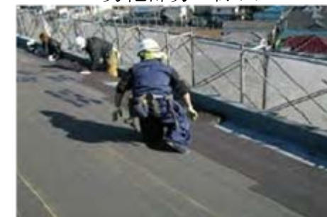
屋上防水改修
