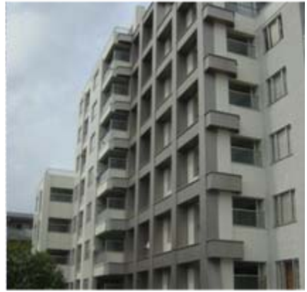
■ 耐震改修(フレームの設置)
