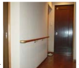
■ 手すりの設置
