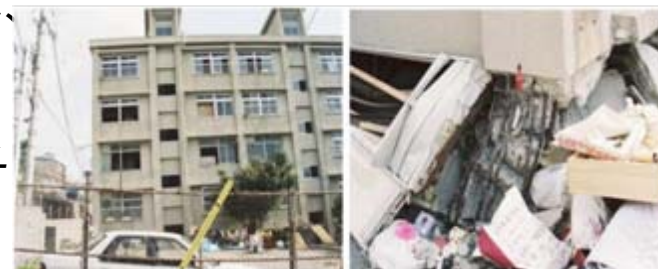
RC造・ラーメン構造(5階建)地震により1階部分が圧壊
