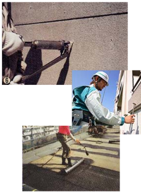
■ 計画修繕 外壁の補修や屋上防水を定期的を実施
