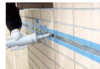
シーリング材の充填
