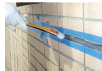
プライマーの塗布
