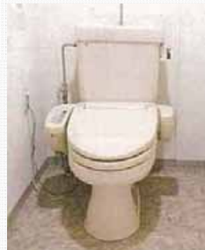
水廻り設備の改修 (トイレ)
