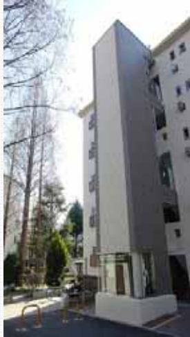
エレベーターの設置
