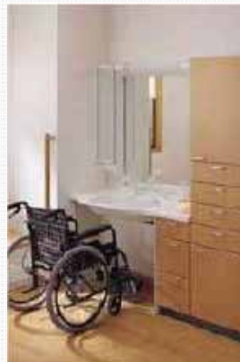
水廻り設備の改修 (洗面台)
