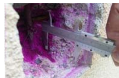
④中性化深さの測定
