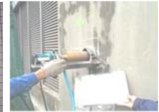
コア強度試験による コンクリート強度の確認 (破壊調査)
