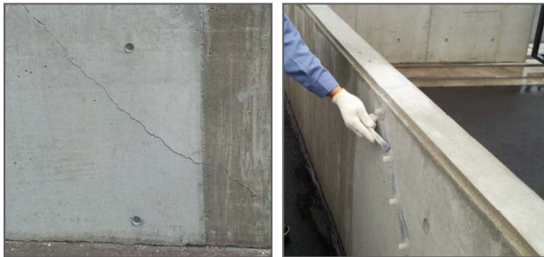
注入工法による補修
