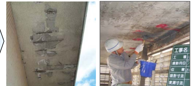
断面修復工法による補修
