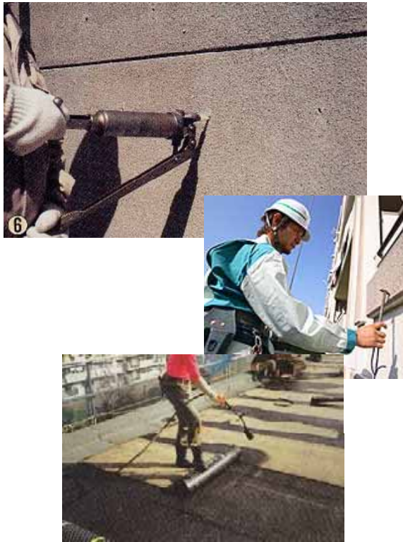
計画修繕 外壁の補修や屋上防水を定期的 to 実施
