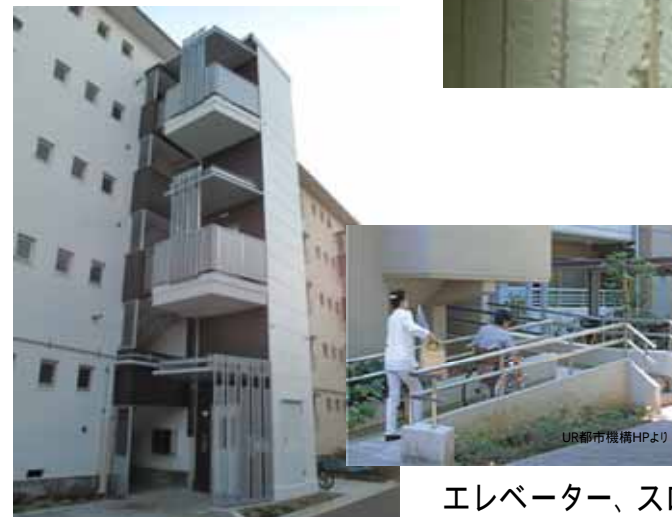
耐震改修(フレームの設置)
