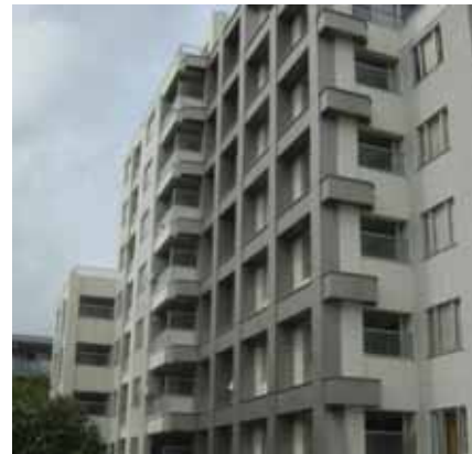
耐震改修(フレームの設置)
