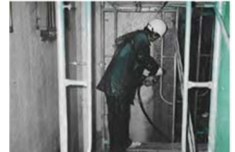
劣化部分の除去
