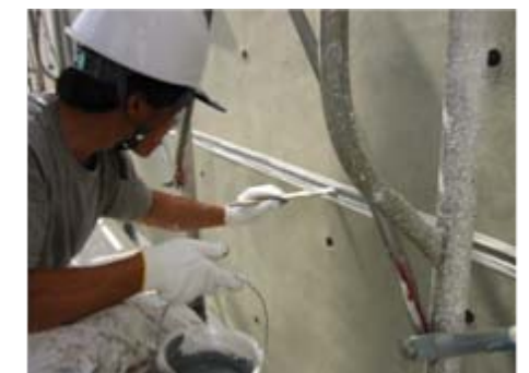
シーリング改修
