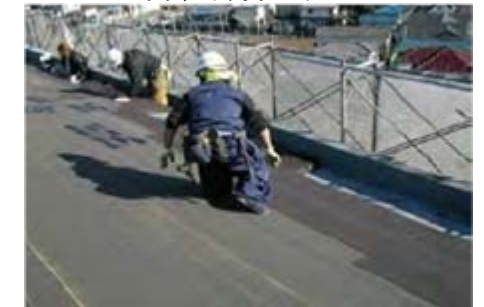
屋上防水改修
